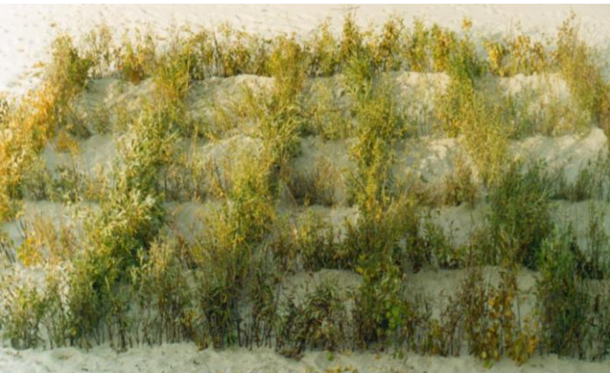
Клеточные защиты у подножия дюны для задержания песка
