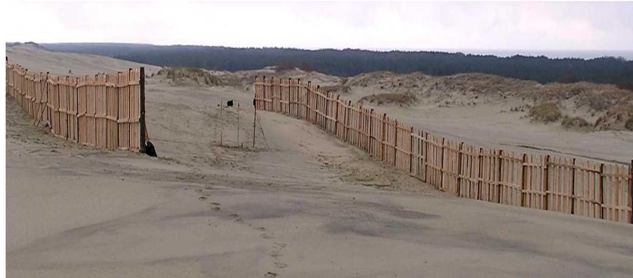
Щиты-заборы на подвижных дюнах для задержания песка в НП «Куршская коса»
